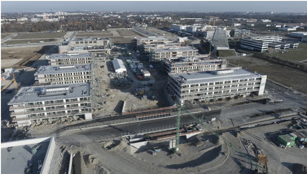
Bild 2: Bildungscampus Freiham: Drohnenfoto von der Baustelle
