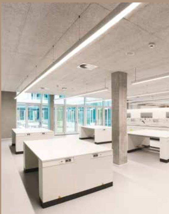
Decken mit HERADESIGN® superfine Holzwohle-Akustikplatten sorgen für ein angenehmes Lernklima in Klassen und Fachräumen.
