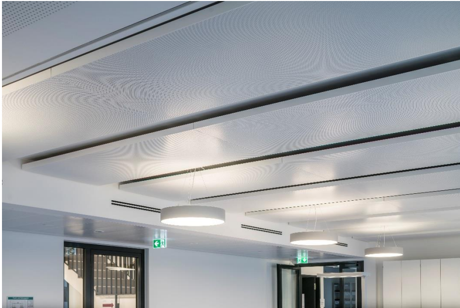
climatt® Metallakustikdeckensegel mit Lüftungshaube zur Abführung von Kühl- und Heizlasten
